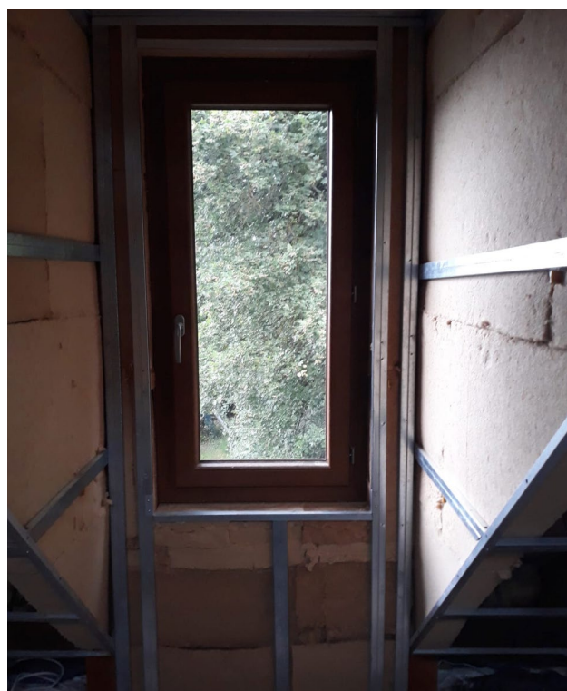
Exemple pour une fenêtre de toit « verticale »
