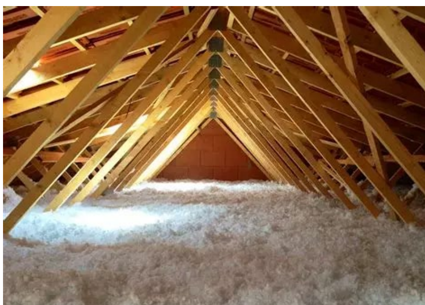
Isolation soufflée entre fermettes
