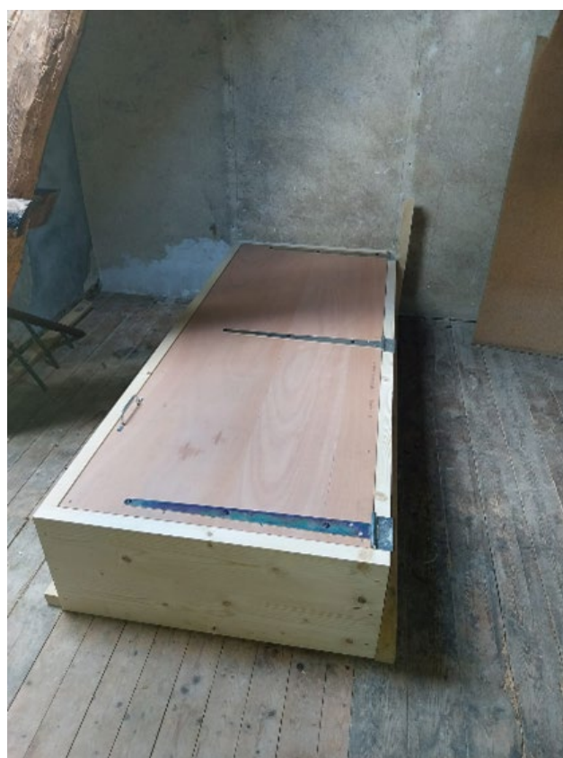
Trappe d'accès aux combles avant pose de l'isolant
