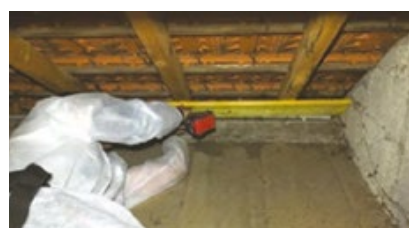
Mise en place d'un déflecteur en bas de toiture
