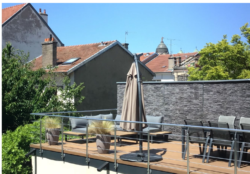
Toiture terrasse accessible
