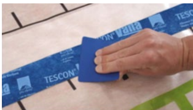
Mise en œuvre membrane Tescon Vana
