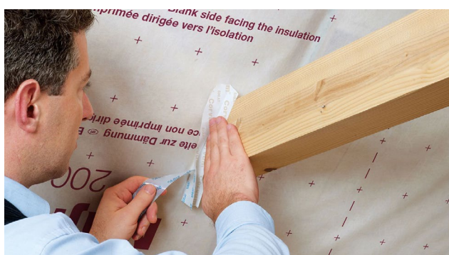
Mise en œuvre membrane Siga Corvum
