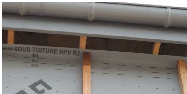
Photo jonction membrane
