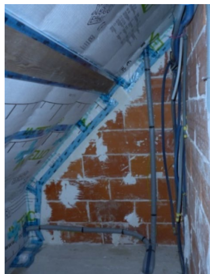
Frein vapeur raccordé sur cloison
