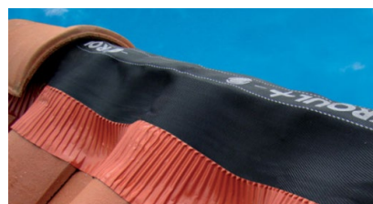
Exemple de closoir souple assurant la ventilation
