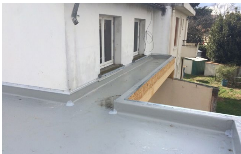
Toiture terrasse accessible
