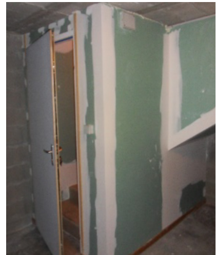
Cage d'escalier en sous-sol permettant son isolation
