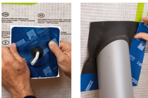
Étanchéité des réseaux sur membrane
