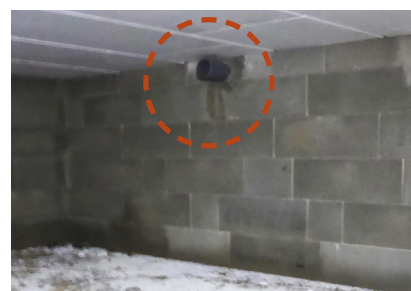
Exemple d'aération d'un vide sanitaire
