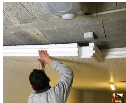
Isolant rigide sous plancher
