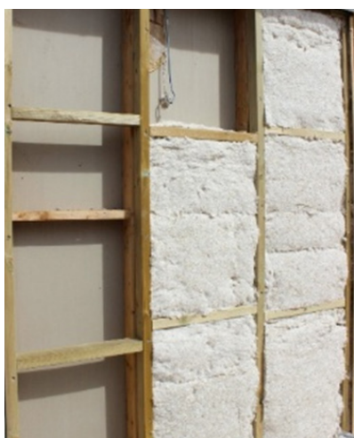
Pose ITE isolant chanvre entre ossature
