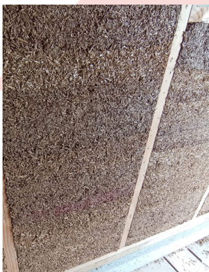
Banchage d'un mélange terre chanvre
