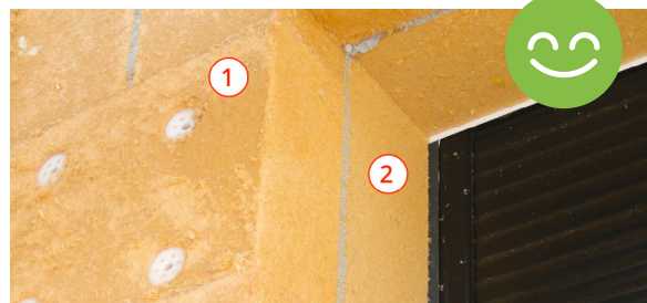
Raccord entre menuiserie et mur et détail de mise en œuvre
