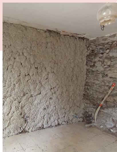
Application manuelle d'un mélange chaux liège
