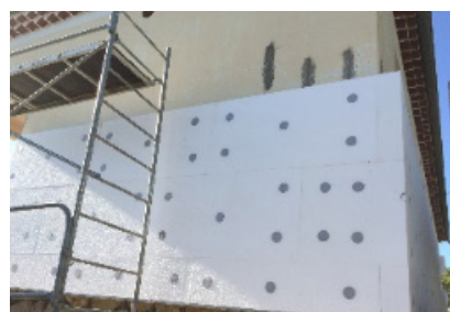
Bouchons d'isolants sur cheville
