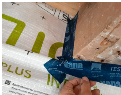
Exemple de raccord membrane / solive avec adhésif
