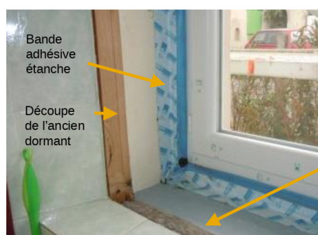
Raccord entre menuiserie et mur et détail de mise en œuvre
