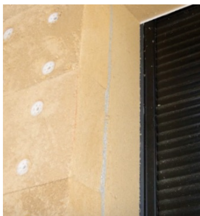
Exemple d'isolation de tableaux et de linteau
