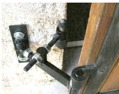
Gond pour déporter les volets avec une ITE
