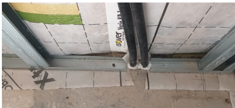
Calfeutrement des réseaux dans leur gaine
