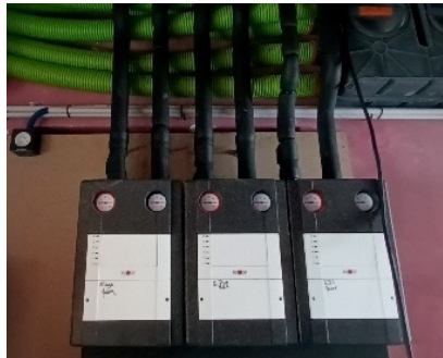
Isolation continue sur une installation
