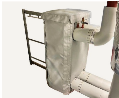
Jaquette isolante échangeur
